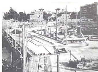
20 agosto 1934, posa della volta del primo piano.
